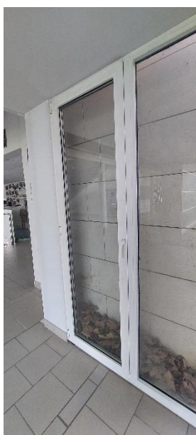
Portes d'accès simple vitrage
