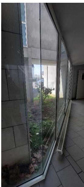
Simple vitrage sans joint dans les couloirs
